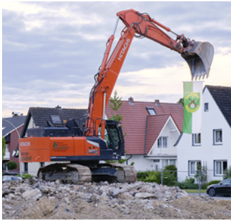
Bagger beim Abriss des alten Kolpinghauses.
